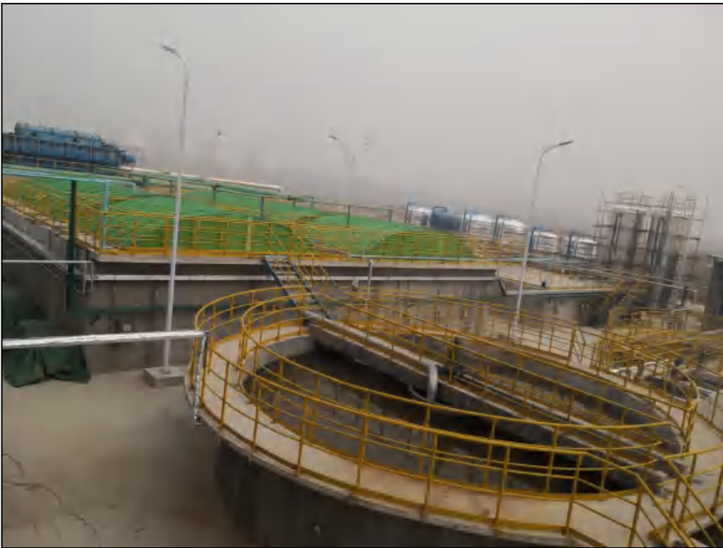
图 4.1 污水处理站现状
