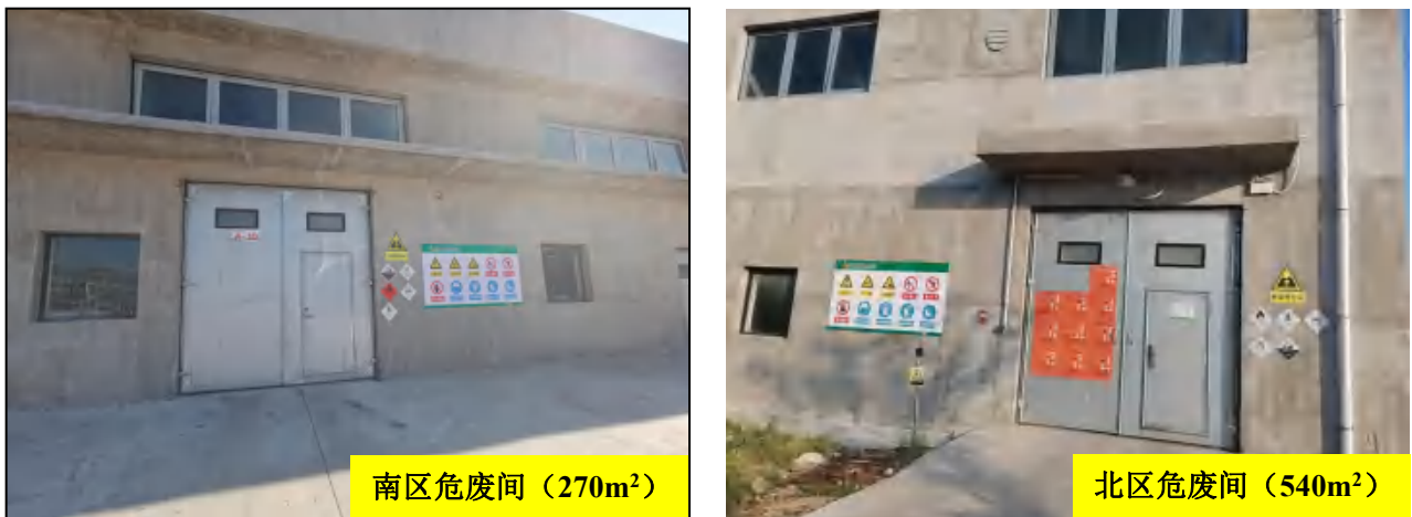
图4.3 危废暂存间现状
